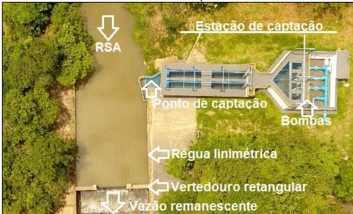
Figura 3 - Fotografia aérea ilustrando os componentes da estação de captação de água da SAGEAGO em Iporá.
