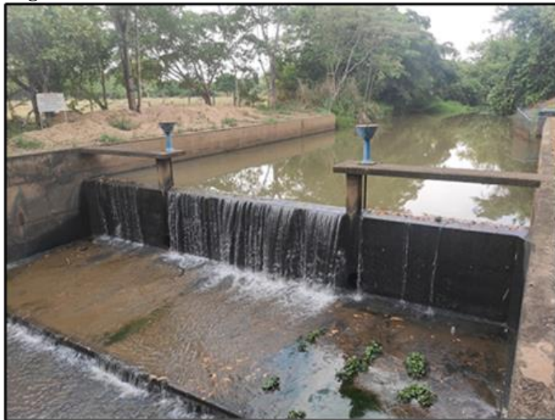
Figura 11 - Vazão remanescente no vertedor em 04/11/2019.
