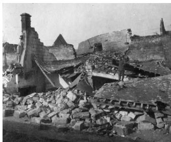
Unternehmen „Alberich“ – gesprengte Häuser in Leuilly, 1917 (Bundesarchiv, Bild 201-21-02-13-342)
