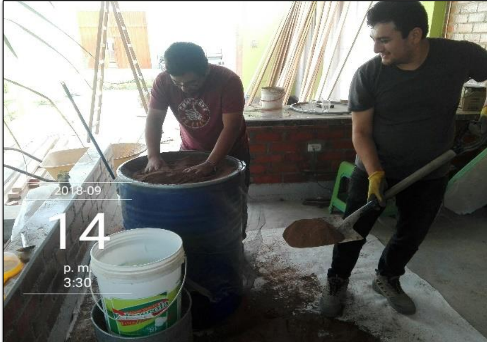
Figura 3: Tamizado de arcilla.
