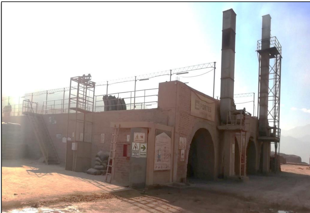
Figura 46: Vista panorámica de la ladrillera industrial.
