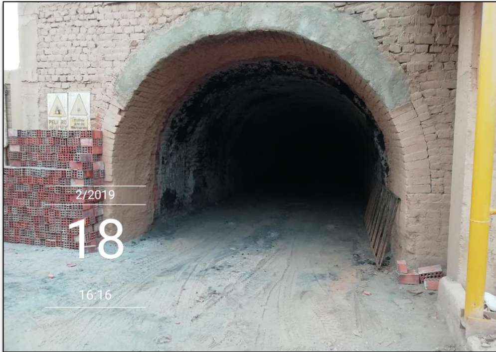
Figura 39: Ingreso de horno industrial.
