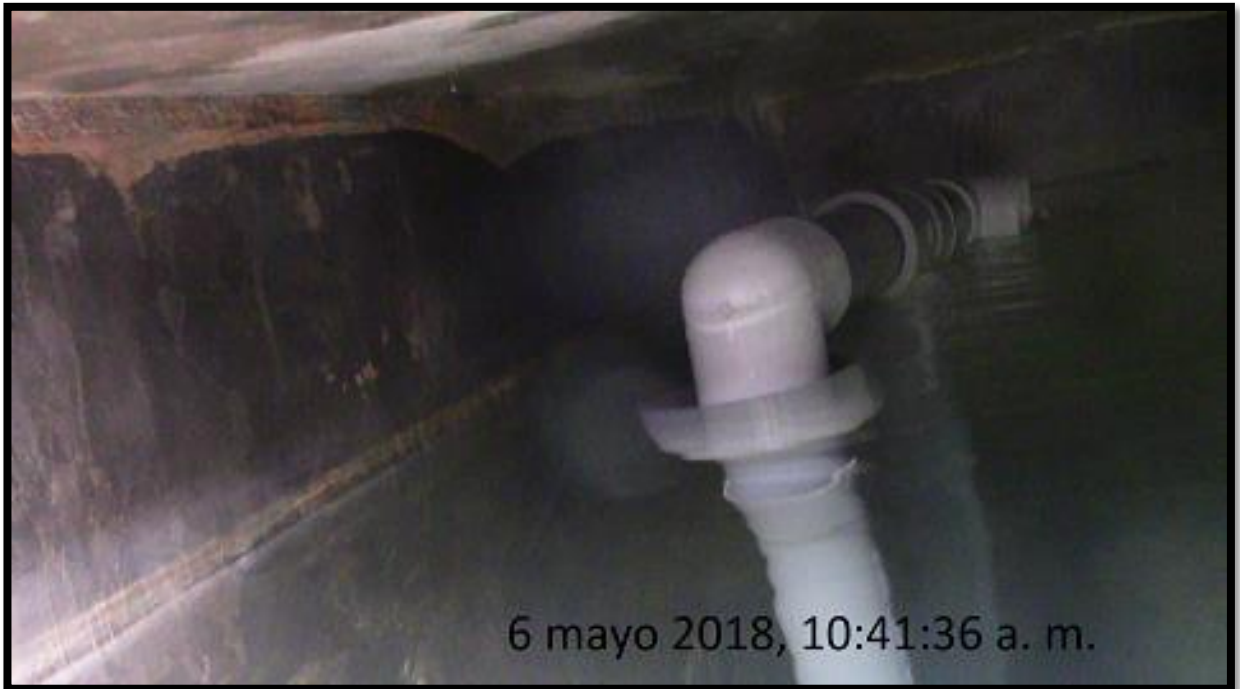
Nivel estático del reservorio del sistema de agua potable morcilla alta
