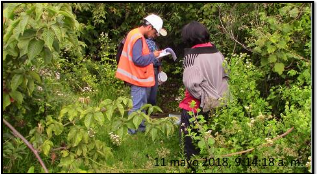
Captación 2 del sistema de agua potable del caserío Cebadin
