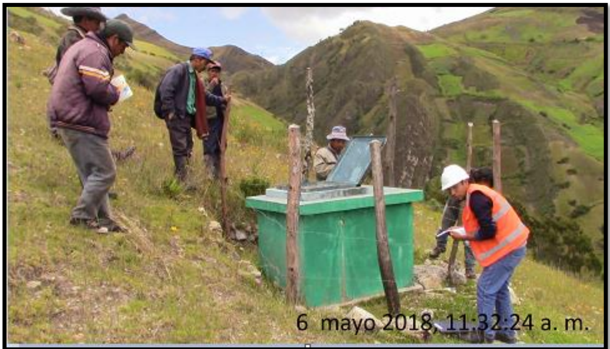
Verificación de cámaras rompe presiones restantes del sistema
