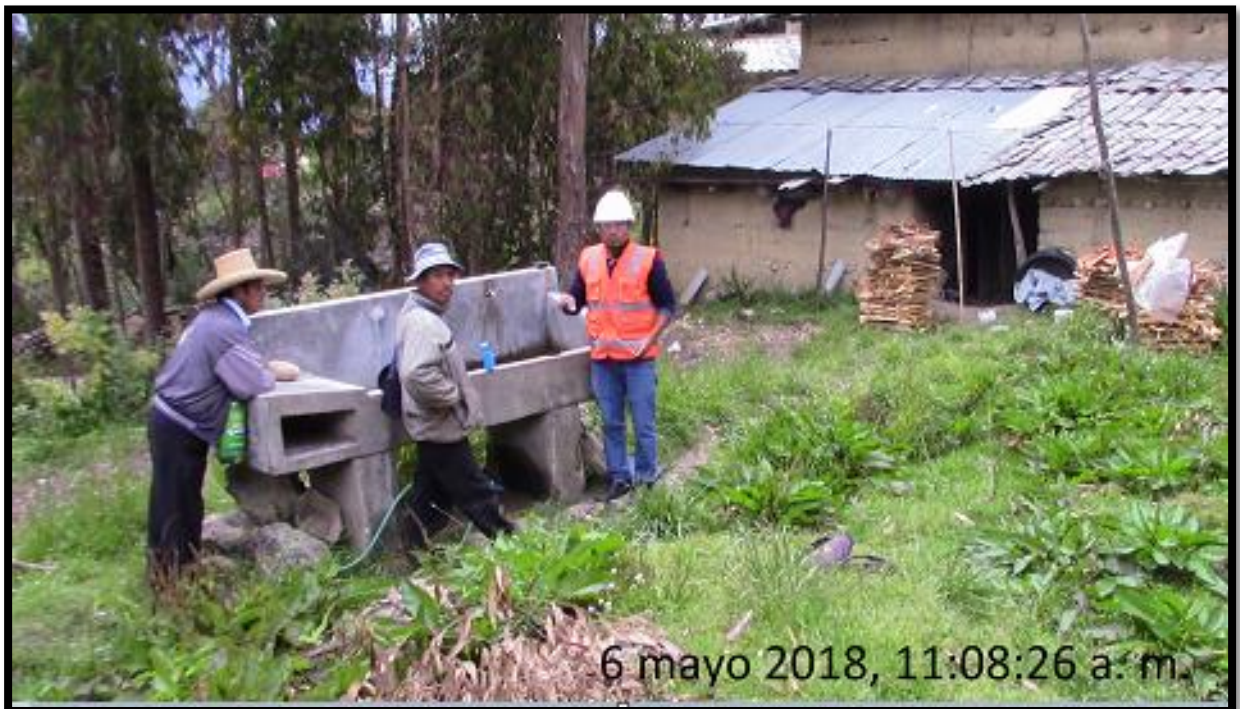
Toma de prueba de cloro casa media del sistema de agua potable Morcilla Alta
