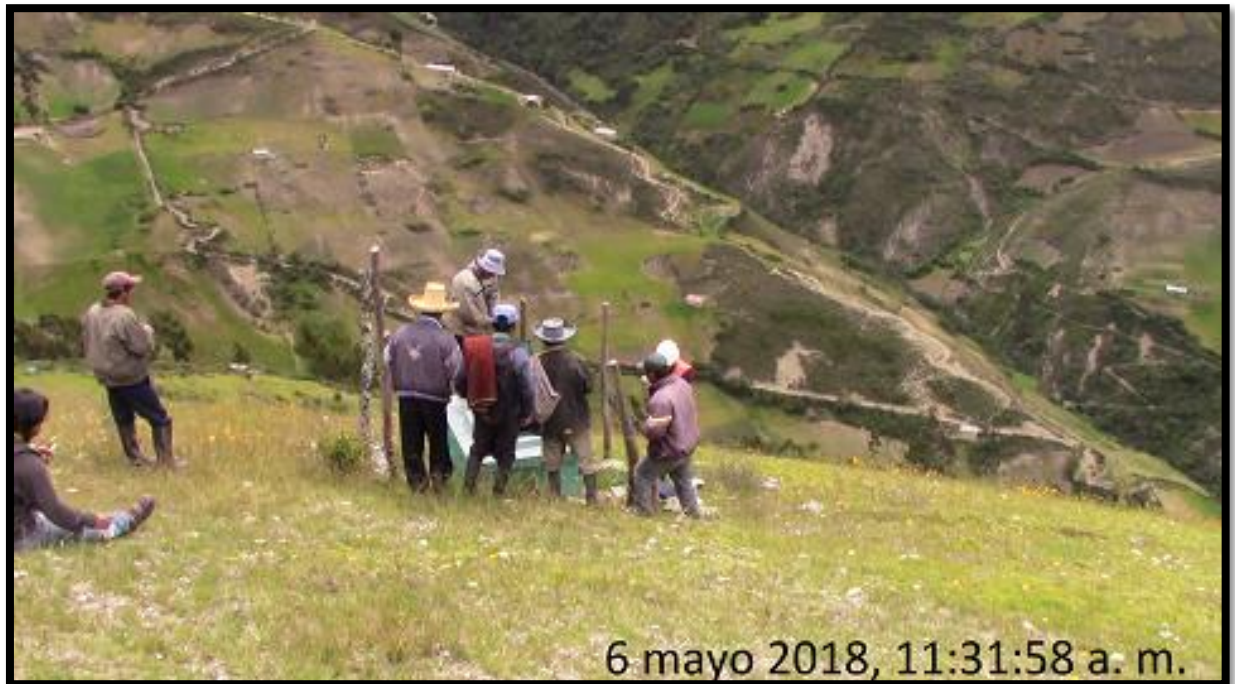
Verificación de cámaras rompe presiones restantes del sistema
