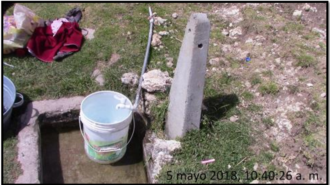
Piletas con pedestal, pero no la usan.
