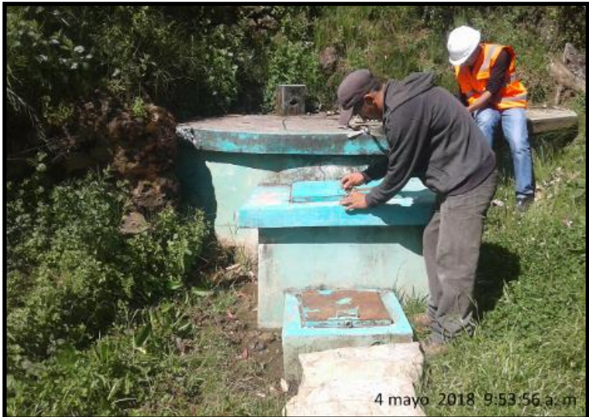
Verificación de la captación la challuas Huayanmarca
