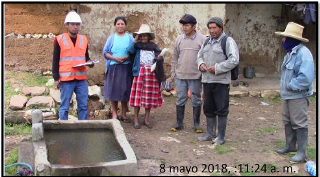
La pileta se observa que se encuentra en buen estado
