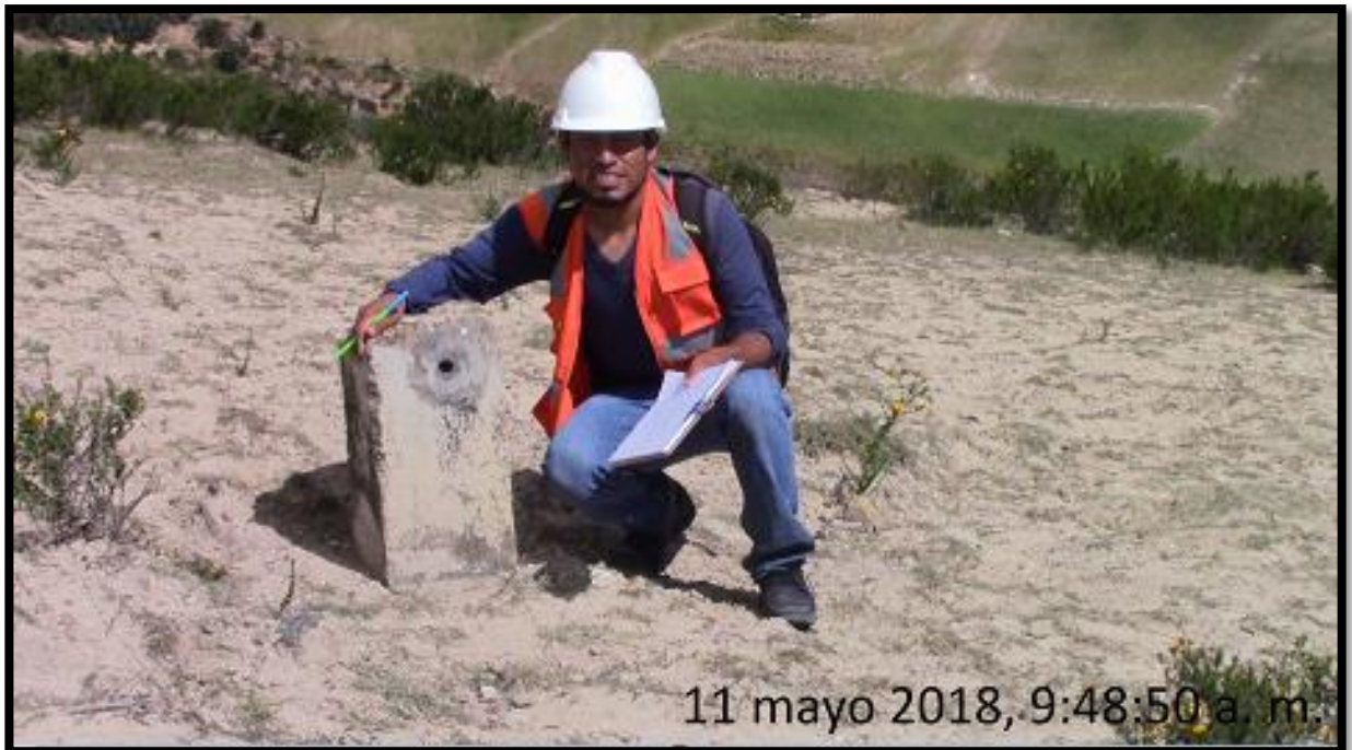
Válvula de rompe carga se observa que se encuentra en buen estado Reservorio
