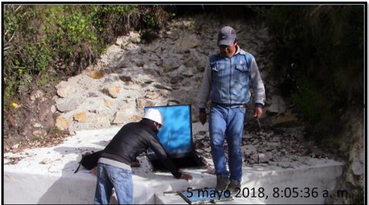
Captación Romero Calzada
