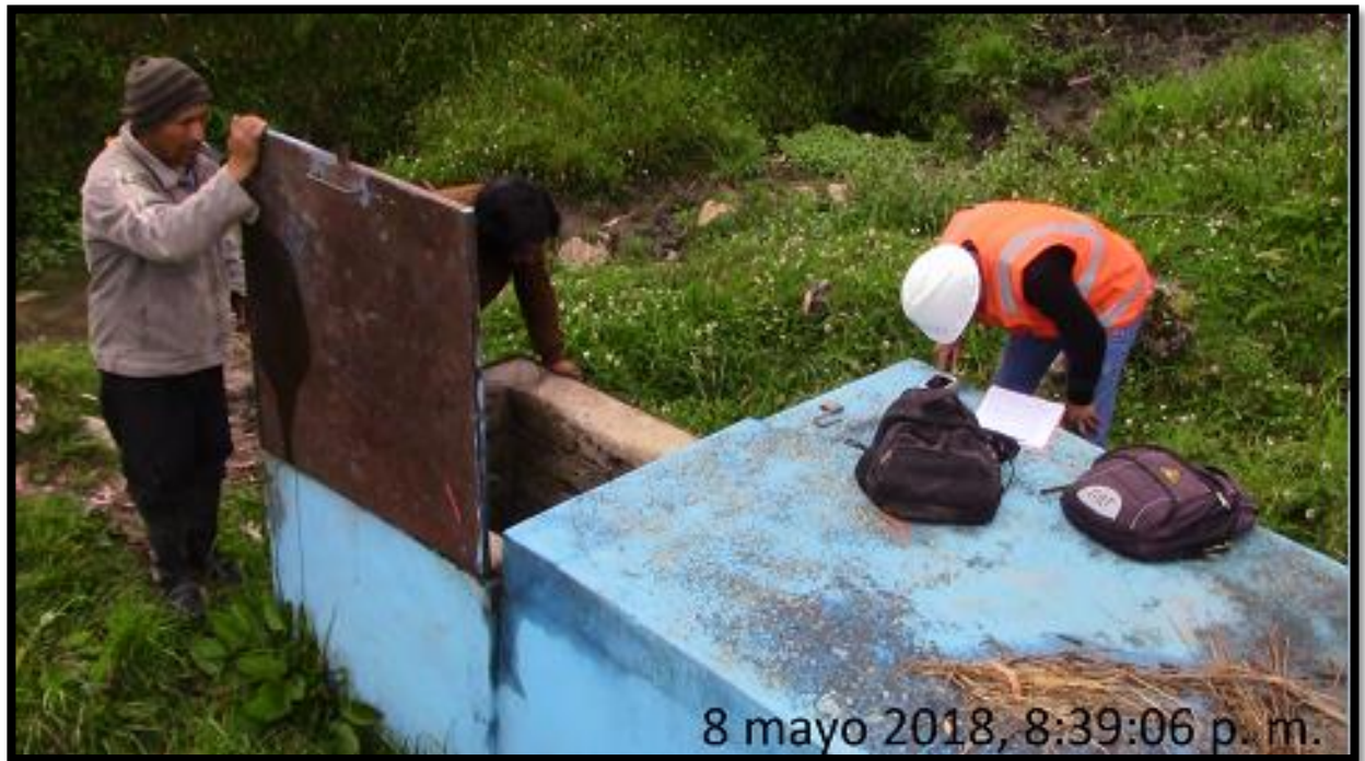
Verificación de la captación del sistema de agua potable Laymina las Mercedes
