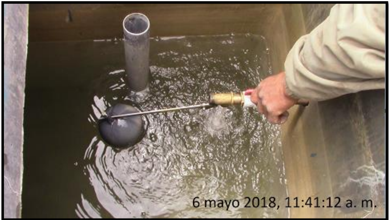
Verificación de cámaras rompe presiones restantes del sistema (interior)
