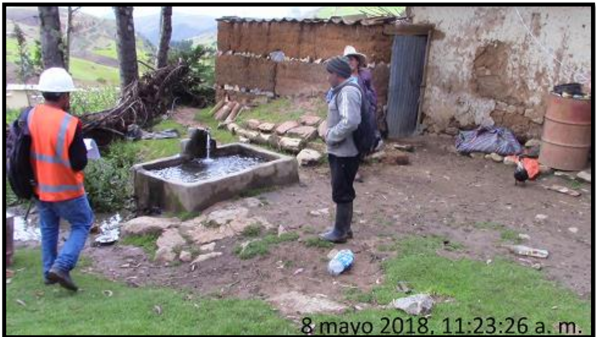
La pileta se observa que se encuentra en buen estado
