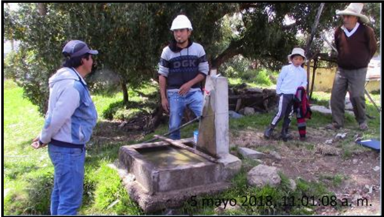
Pileta media haciendo la prueba de DPD y se observa que su pileta se encuentra en buen estado.
