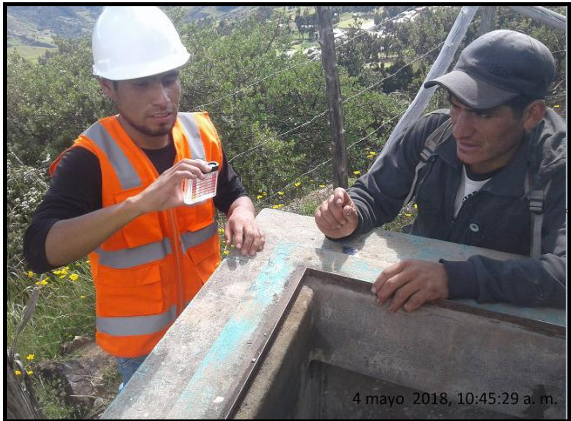
Medición de la calidad de cloro DPD en reservorio Red de aducción o distribución
