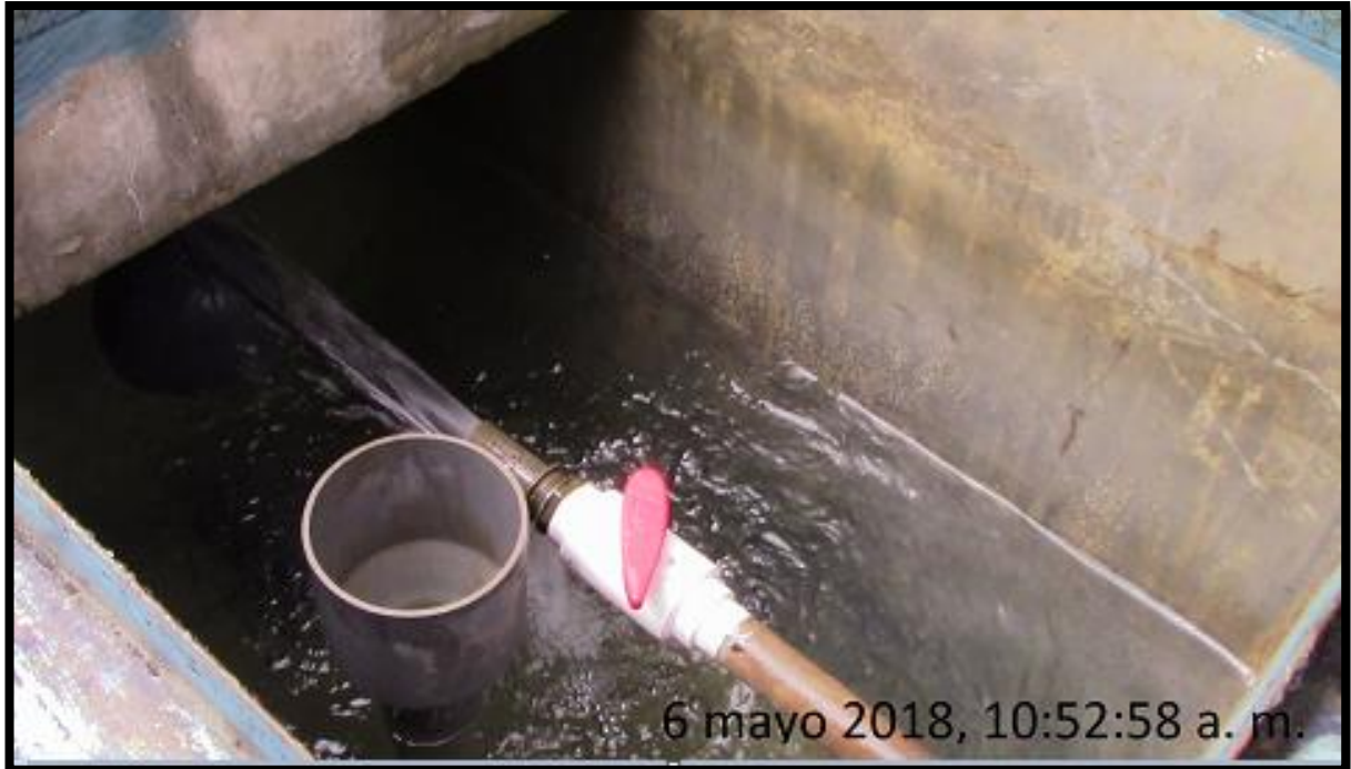
Verificación de cámaras rompe presión tipo 7 del sistema de agua potable Morcilla Alta
