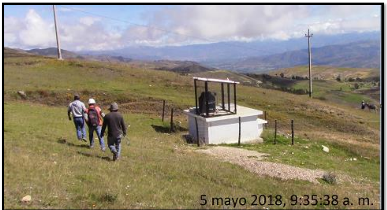
Llegando hacia el reservorio del sistema de agua potable de La Tranca 1.
