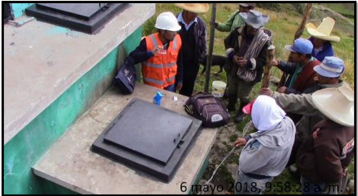
Reservorio del sistema de agua potable Morcilla Alta
