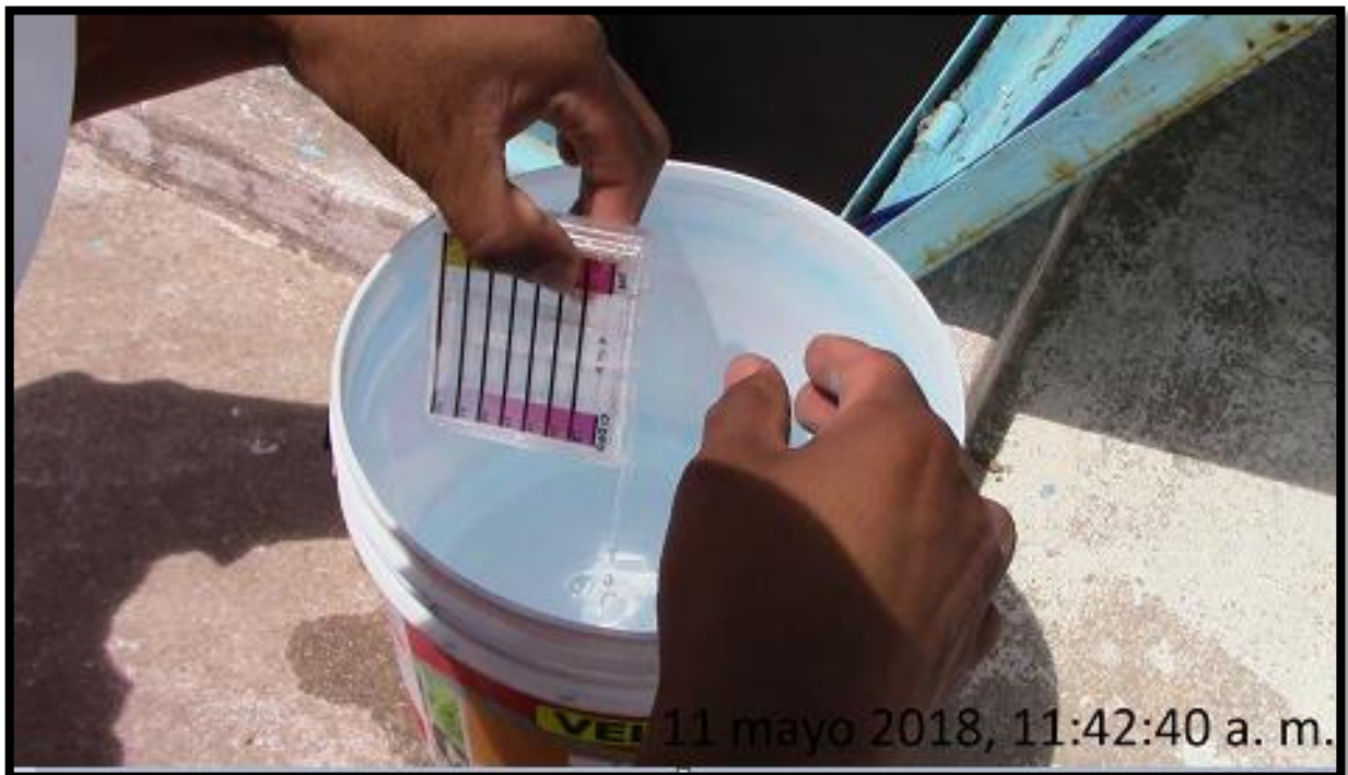
Prueba de cloro DPD en reservorio se observa en buen nivel
