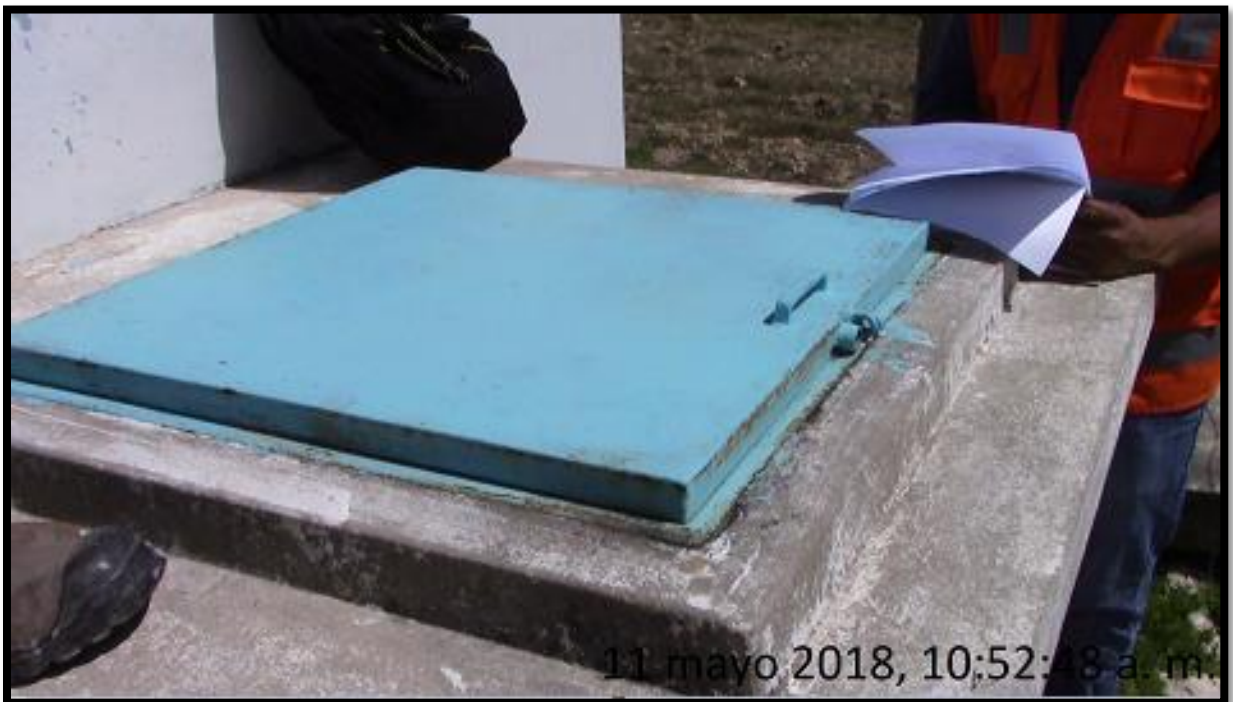
Verificación del reservorio 1 del sistema de agua potable
