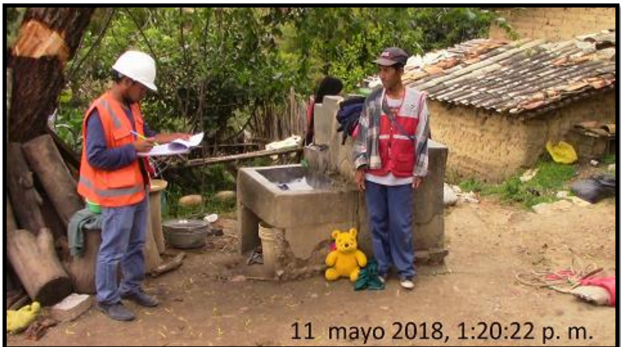
Se observa que el pedestal se encuentra en buen estado
