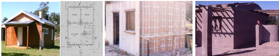
Figura 2: Vivienda Experimental de Madera Figura 3: Viv. Experimental de Placas de Ladrillo Figura 4: Viv. Experimental de Suelo Cemento
