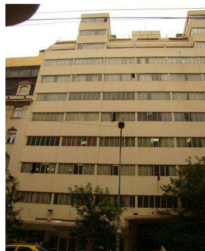
Figura 7. Edificio de la Procuración - Uruguay 440
