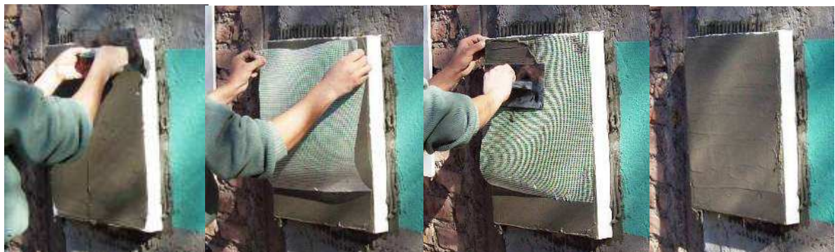
Figura 1: Sistema Weber: 1- untar el muro y una cara el aislante; 2- unir ambas partes y presionar bien; 3-4 untar la cara visible del aislante; 5-6 colocar la malla de PVC untando nuevamente la cara visible; 7 dar terminación a la superficie alisando para dejarla lista para recibir la pintura.
