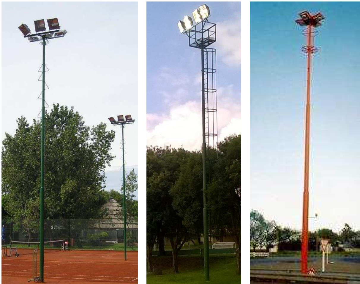
Figura 1: Postes de sección variable por tramos
