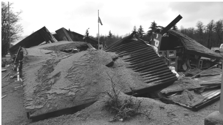
Figura 8. Los efectos de la ceniza volcánica en los techos. Paso Internacional Cardenal Samoré, Neuquén. 2011. Imagen captada el 8 de Junio de 2011, 4 días después de iniciada la erupción. Fuente: Gustavo Villarosa y Valeria Outes.
