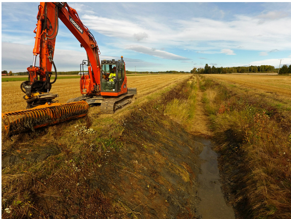
Kuva 19. Niittokauhan avulla voidaan poistaa uomasta kasvillisuutta. Kuvassa Renkoolan oijen puhdistusperkausta niittokauhalla Isokyrössä kesällä 2018.
