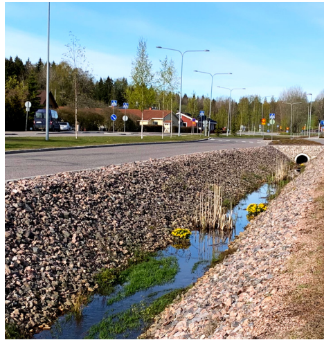
Kuvat 16 ja 17. Luonto alkaa muovata suoristettuja uomia kohti luontaista tasapainotilaa. Leveäksi kaivetun uoman pohjalle alkaa usein muodostua kasvillisuutta ja uutta mutkittelua, kun vesi hakee uuden linjauksen kasvillisuuden seassa.
