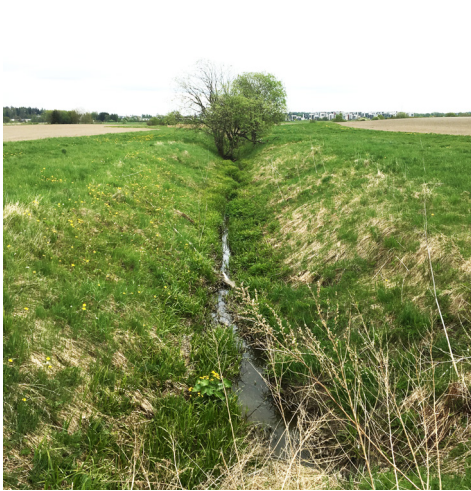
Kuvat 16 ja 17. Luonto alkaa muovata suoristettuja uomia kohti luontaista tasapainotilaa. Leveäksi kaivetun uoman pohjalle alkaa usein muodostua kasvillisuutta ja uutta mutkittelua, kun vesi hakee uuden linjauksen kasvillisuuden seassa.
