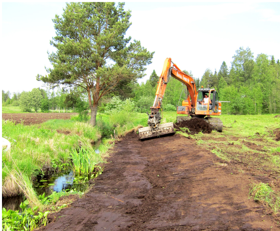
Kuva 18. Tulvatasanteiden avulla voidaan usein vähentää eroosiota ja kiintoaineksen päätymistä alapuoliseen vesistöön. Turvemaille humuksen huuhtoutuminen voi vähentyä.
