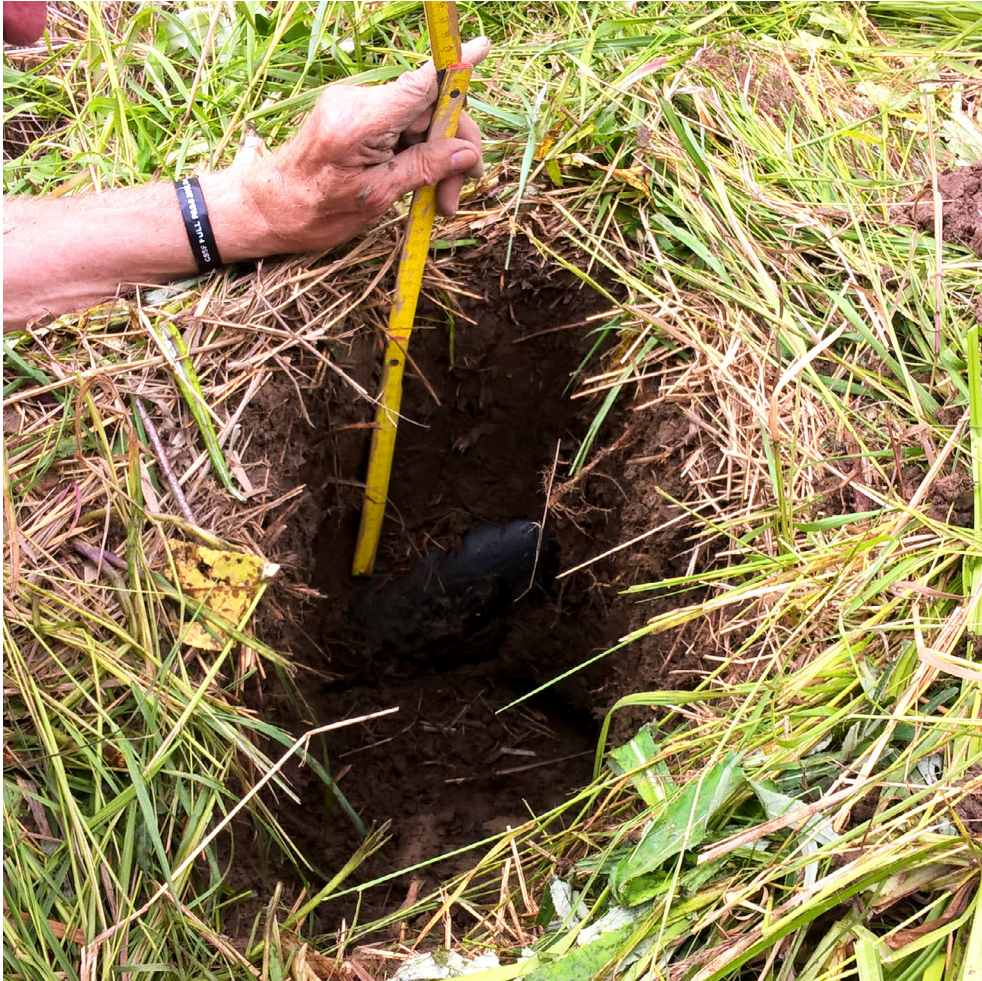
Kuva 20. Juottimenojalla tulvatasanteelle on paikotellen kertynyt kiintoainesta 10 vuodessa jopa yli 20 senttimetriä. Salaojaputket kulkivat tulvatasanteen yli vuonna 2008, kuvassa vuonna 2018 tulvatasanteella esiin kaivettu salaojaputki.
