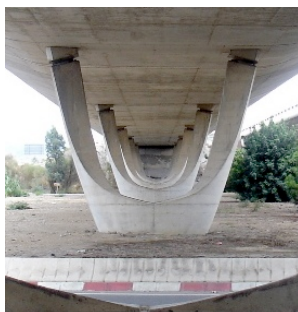
Imagen 1. Pilares de un puente. Vélez-Málaga (Málaga).
