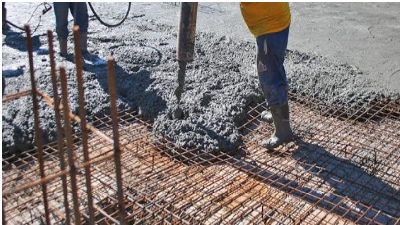
FIGURA 67 COLOCACIÓN DE CONCRETO EN UNA OBRA
