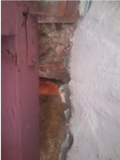
FIGURA 74 PARED DEL TEMPLO, SE OBSERVA LADRILLO DE BARRO COCIDO
