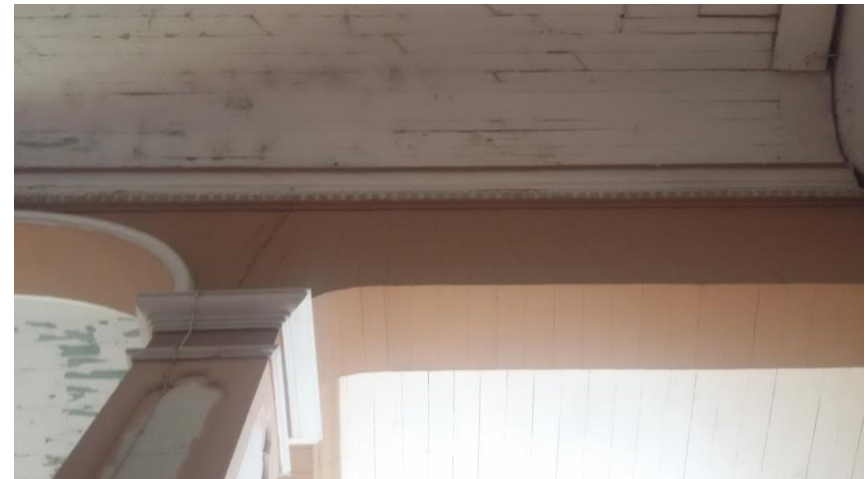
FIGURA 73 CIELO FALSO DE MADERA DENTRO DEL TEMPLO
