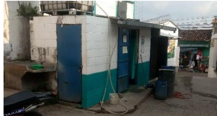
FIGURA 100 FOTOGRAFIA ACTUAL DE BAÑOS
