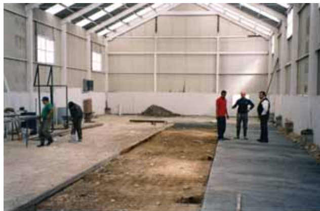
▲ Construcción de la nave para el Taller de Fundición en la Unidad Churubusco, 2005.
