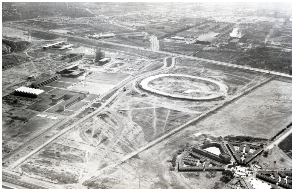
Imagen 6. Vista aérea de la CUNL en construcción (segunda etapa), ca. 1960. Se observa la torre de Rectoría en proceso de edificación y la preparación del terreno para el Estadio Universitario. Fuente: CDAH-UANL (Monterrey, México).
