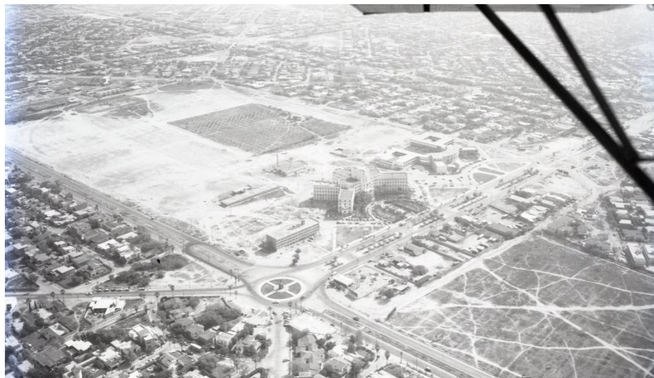
Imagen 1. Terreno colindante con el Hospital Civil “José Eleuterio González”, edificación central, ca. 1960. En la imagen se pueden observar los inmuebles de la Facultad de Medicina (derecha) y la Casa de la Enfermera (izquierda) para la escuela de Enfermería. Con el tiempo se conformaría ahí el Área Médica de la Universidad Autónoma de Nuevo León. Fuente: Centro de Documentación y Archivo Histórico de la UANL (CDAH-UANL, Monterrey, Nuevo León).
