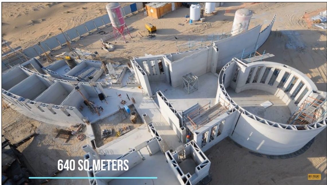
Obrázek 10 - Vytisknutá budova v Dubaji společností Apis-cor. 42
