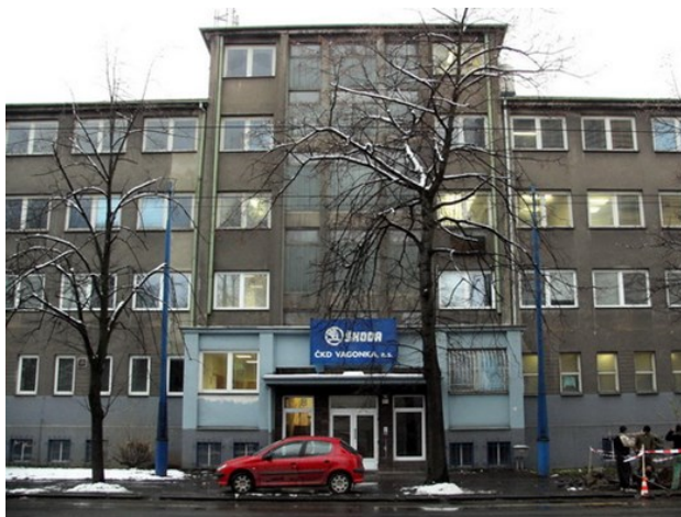
Obrázek 1.2 – Budova firmy v Ostravě – Vítkovicích [2]
