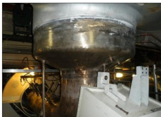
Obrázek 6 – (nalevo) parogenerátor DN 1100, (napravo) heterogenní svarový spoj kolektoru [8]
