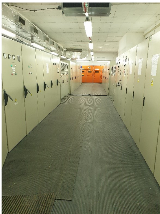
Obrázek 6.1 Trafostanice TS4 se systémem automatického zásokou
