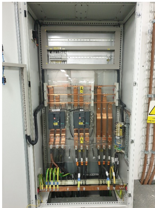
Obrázek 6.1 Trafostanice TS4 se systémem automatického zásokou
