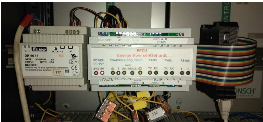
Obr. 3-15 Nainstalovaná řídicí jednotka EFCU v rozváděči
