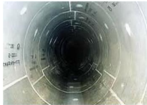
(d) mini-shield segment after construction execution
