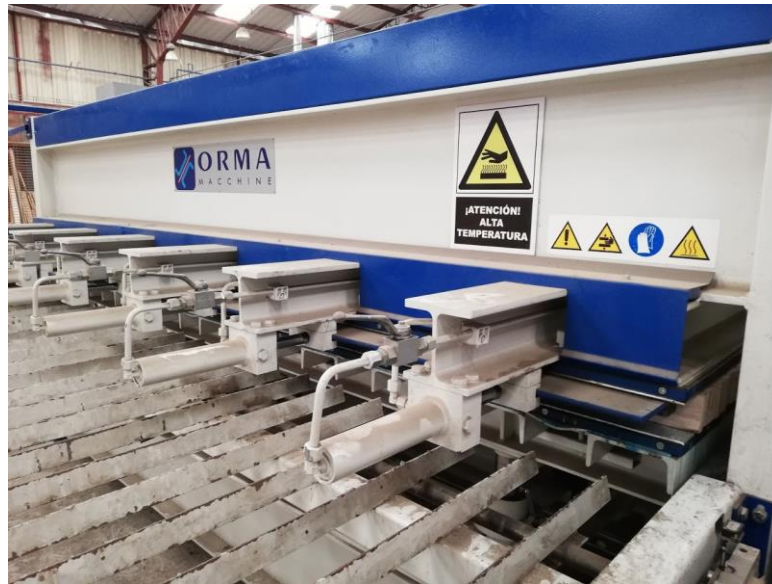
Figura 30. Prensado de las vigas MLE.
