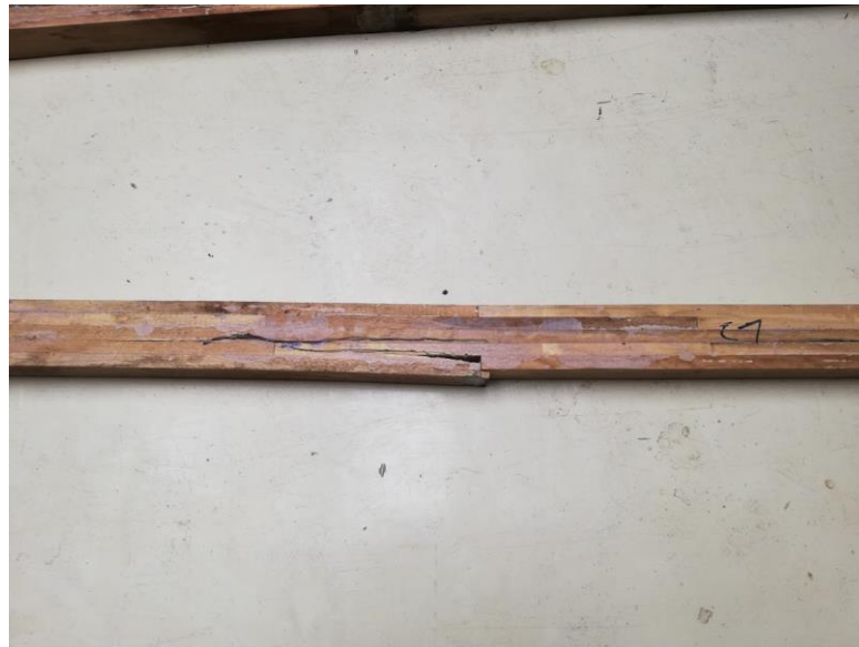
Figura 47. Falla por desprendimiento en las uniones, viga Canelo-FJ #1.
