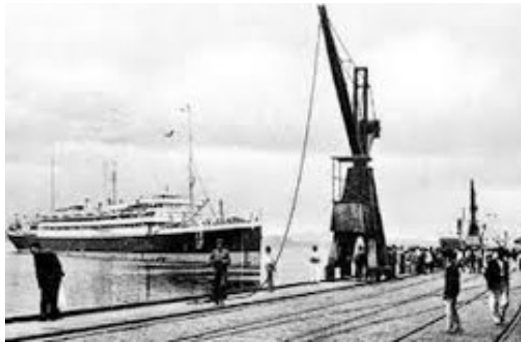
Figura 1-Navio Nasmith atracando no primeiro trecho de cais.
