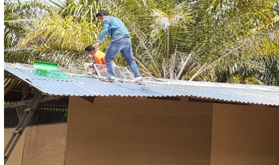
Gambar 9. Pemasangan panel surya
