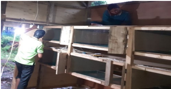
Gambar 7. Pemasangan instalasi penerangan di kandang DOC
