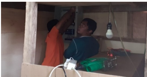
Gambar 8. Pemasangan mesin tetas dan panel kontrol
