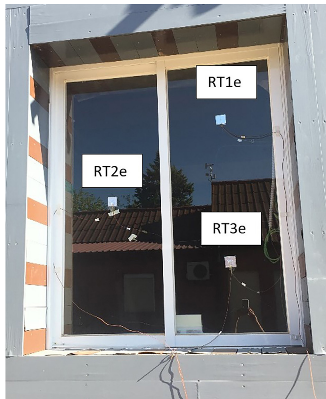
Figura 11. Posición de los termopares en los acristalamientos. Ventana de Referencia.
