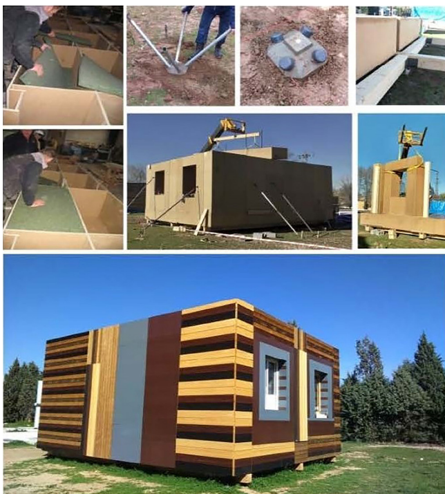
Figura 1. Imagen del Laboratorio REVEN -IETcc-CSIC. Fotografías de las diferentes etapas de construcción.
