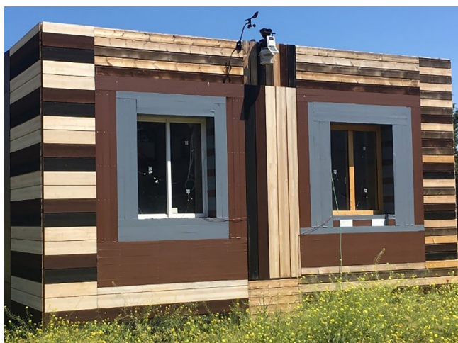
Figura 5. Fachada Sur del Laboratorio REVen. A la izquierda ventana de referencia, a derecha ventana optimizada.
