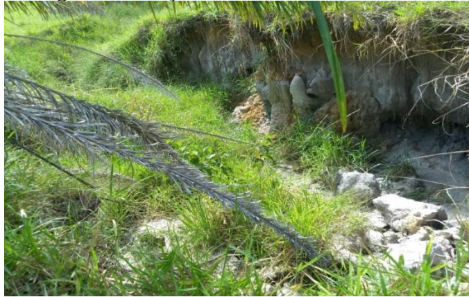
Figura 3 – Voçoroca a montante da nascente.
