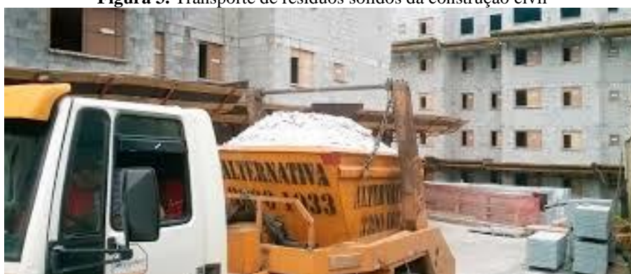
Figura 3. Transporte de resíduos sólidos da construção civil
