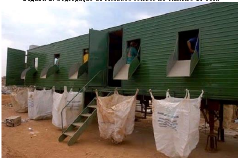
Figura 1: Segregação de resíduos sólidos no canteiro de obra
