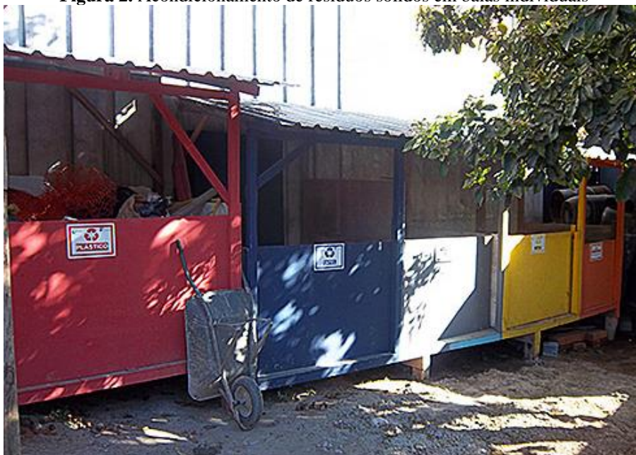
Figura 2. Acondicionamento de resíduos sólidos em baias individuais
