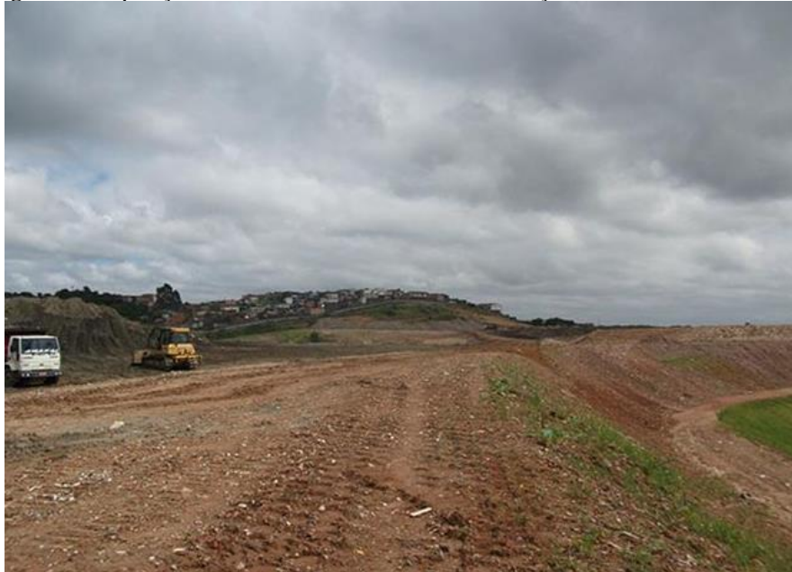
Figura 5. Disposição final de resíduos sólidos da construção civil em aterro de inertes
