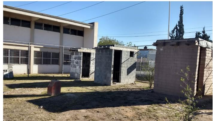
Figura 2. Vista de los módulos (de izquierda a derecha: de bloques de tapa de huevo con termolita y cemento -BTH-, de bloque concreto -BC- y de bloque de tierra comprimida -BTC-). Fuente: Elaboración del autor.
