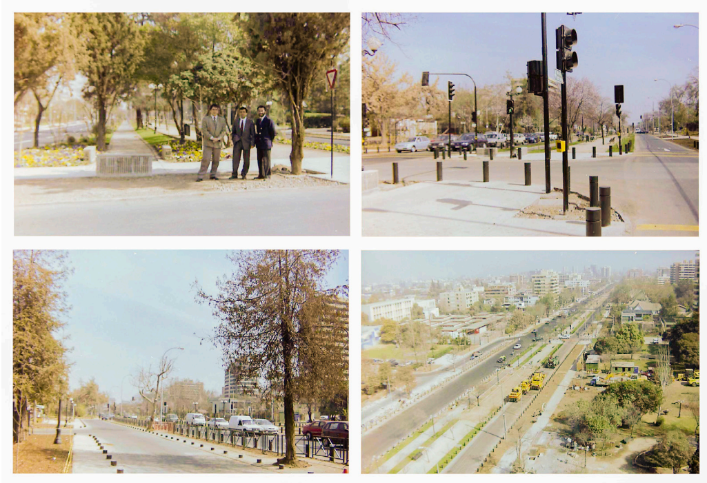
Figura 2. Construcción del Parque Lineal Pocuro en 1997. Fuente: Municipalidad de Providencia
