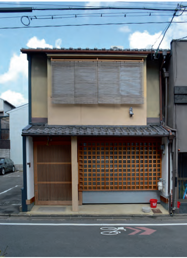
Gae Machiya, renovatie tot woonhuis met gesloten voorgevel Gae Machiya, renovation into a dwelling with closed front façade
