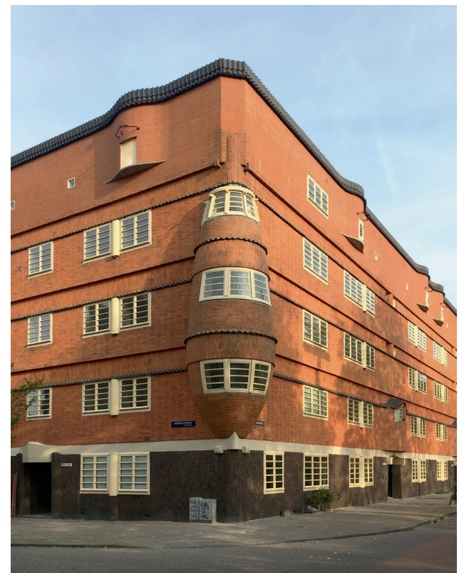
Gevelfragment met baksteenornamenten en ramen met roede-verdeling Façade fragment with brick ornaments and windows with glazing bars
