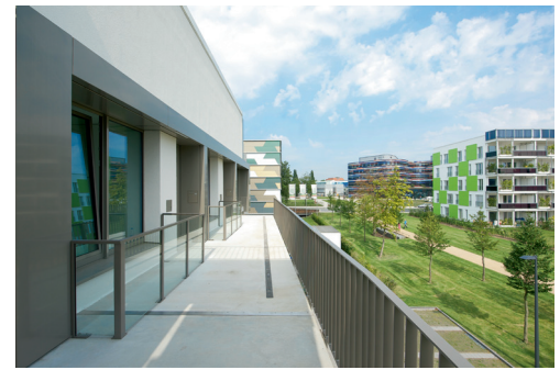
Entrees van de woningen op de tweede verdieping Entrances to the houses on the second floor
