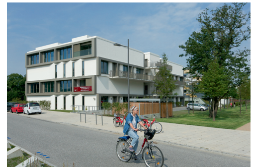
Zuid- en oostgevel South and east façade
