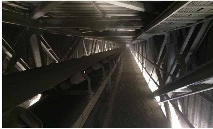
FIGURA 4 – Rampa de acesso aos silos de armazenamento. Fonte: O autor (2016).
