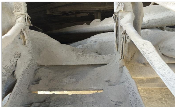
FIGURA 5 – Acesso aos pontos de medição dos silos. Fonte: O autor (2016).
