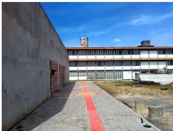
Imagem 8 – Obra da Praça CEU e, aos fundos, edifício do antigo CAIC.
