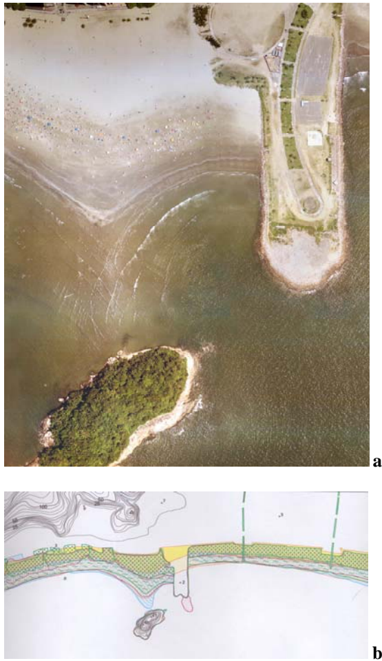
Figura 7: (a) Tômbolo natural criado pela ilha de Urubuqueçaba, ponto natural de sedimentação. A estrutura do Emissário Submarino, situada ao lado, acabou por reter todo o sedimento arenoso que alimentaria as praias situadas a oeste da estrutura (Fonte: Prefeitura Municipal de Santos 2000); (b) Sobreposição das linhas de costa (1962 - laranja, 1977 - azul, 1994 - rosa e 2000 - verde).
