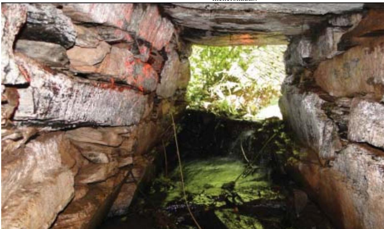
Figura 3:- Duto de pedra de 96m de comprimento usado para o encaminhamento de água para a mineração aurífera. Fonte: Acervo próprio.
