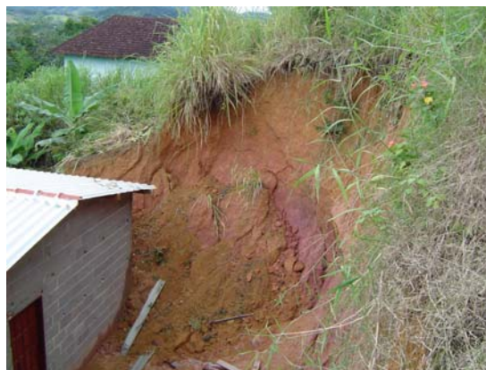
Foto 4: Detalhe do material mobilizado na ruptura de um corte ocorrido no município de Guarujá (SP). O cômodo dos fundos desta moradia foi parcialmente destruído. Fonte: Arquivo IPT.
