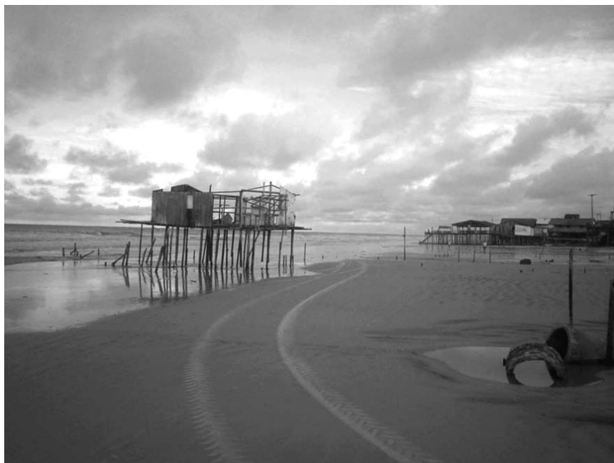
Figura 4 - Destruição de edificações no setor NW da praia de Ajuruteua-PA. Foto: Danielly Guimarães (2004)
