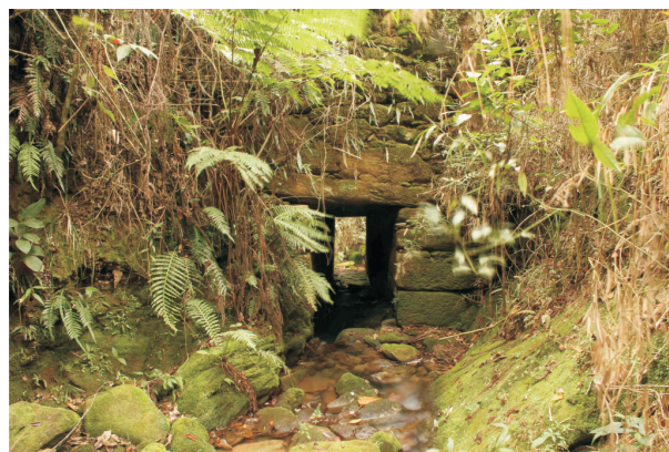
Figura 21 – Vista da ponte do Biquinha em trecho preservado da Estrada Real. Foto: Úrsula Ruchkys de Azevedo.
