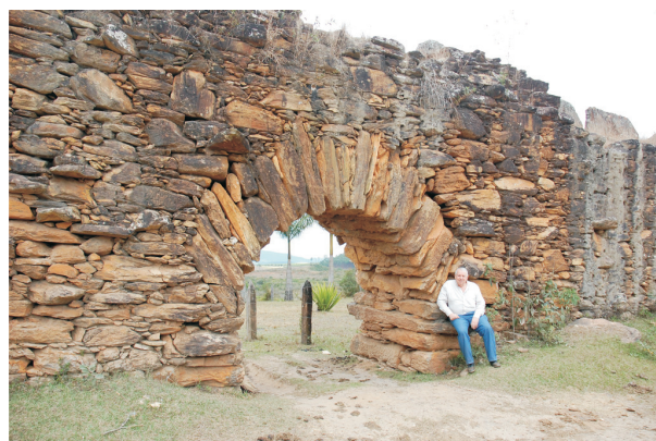
Figura 23 – Aqueduto Bicame de Pedra exibindo portal em arco romano. Foto: Acervo CPRM.
