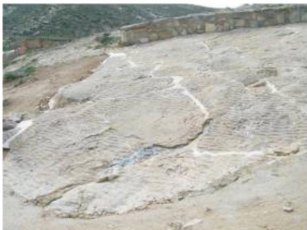
**Figura 31** – Uso de argamassa como solução para preenchimento de fraturas: uso em sítio paleontológico em Aliaga, Espanha (Fotografia de Kátia Mansur, 2009).
