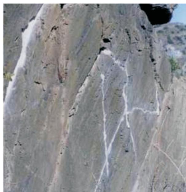
**Figura 30** – Uso de argamassa como solução para preenchimento de fraturas: fraturas em rocha do sítio arqueológico de arte rupestre do Vale do Côa, em Portugal (fotografia extraída de Fernandes, 2008).
