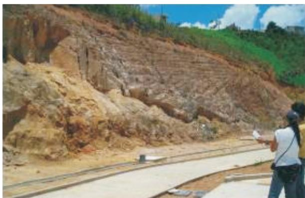
**Figura 17** – Volta Redonda, RJ: construção de praça na tentativa de conter a erosão em afloramento de depósitos sedimentares com evidências de neotectônica, onde se conseguiu evitar o revestimento do afloramento por grama após explicar a importância didática do local para os moradores (Fotografia: Luiza Ponciano, 2007).
