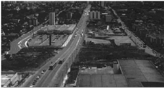
Fotografia 1: Vista do sistema de transporte trinário - sentido nordeste.
