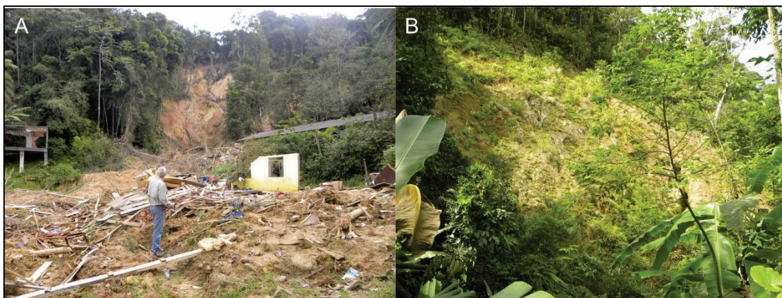
Figura 2 - Movimentos de massa ocorridos no Morro do Bom Brinquedo, em 11 de março de 2011; A) área afetada no setor Sudoeste do Morro e B) cicatriz remanescente de escorregamento do Morro. Fotos dos autores.
