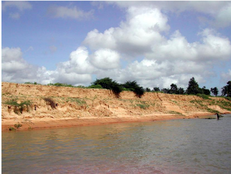
FIGURA 4 - Talude marginal em processo erosivo no perímetro irrigado Cotinguiba-Pindoba, município de Propriá (BANDEIRA, 2005).
