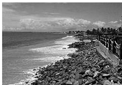
FOTO 4 E 5 – PROCESSO DE MIGRAÇÃO DO CAMPO DUNAR (FOTO 4) – BARREIRA À FONTE DE ALIMENTAÇÃO PRAIA-DUNA (FOTO 5)
