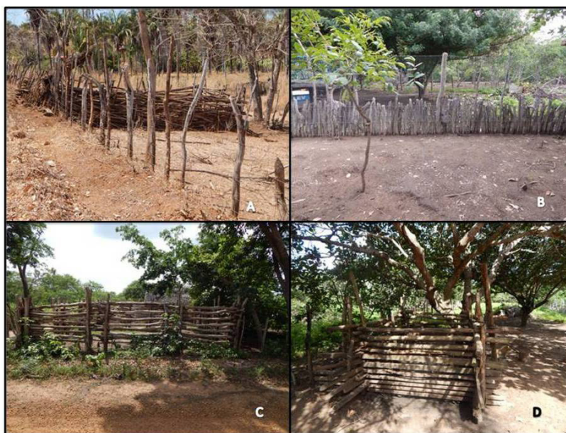
FIGURA 3 – Construções rurais presentes nas comunidades Chapada do Hamilton e Novo Horizonte, Angical do Piauí/PI. A e B - Cercas; C - Curral; D - Chiqueiro. FONTE: arquivo pessoal.
