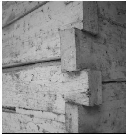
Figura 3. Detalhe da parede da casa de troncos.
