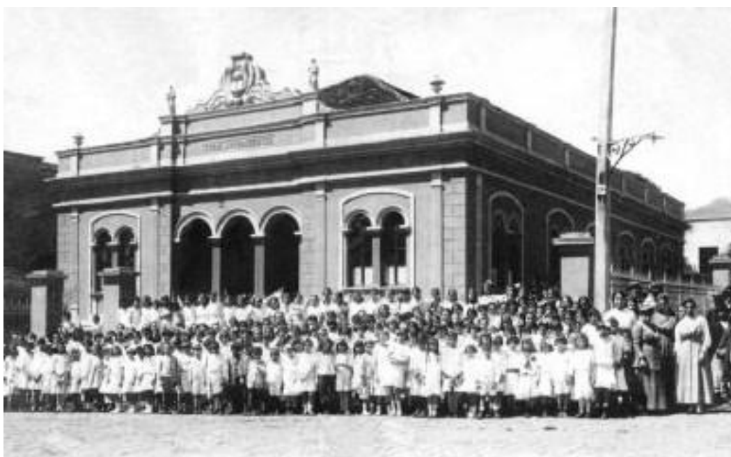
FIGURA 4 - FACHADA DO EDIFÍCIO DO GRUPO ESCOLAR TIRADENTES FONTE: PARANÁ, 1916
