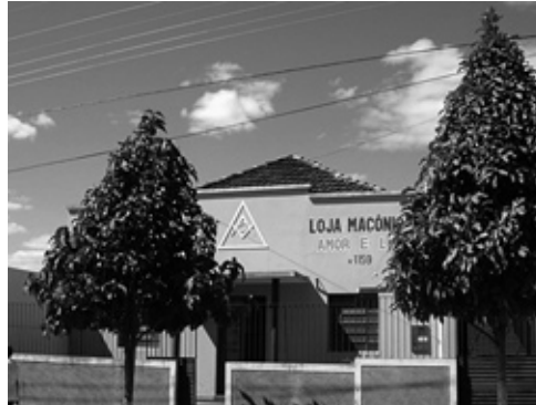
Construção maçônica em uma cidade do interior de Goiás com 28,6 mil habitantes (Foto: Suely Kofes).
