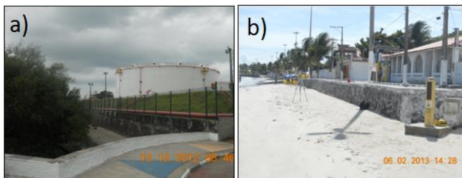
Figura 2: Ilustração de alguns trechos da zona de praia sob pressão antrópica (Pontos P1 e P2 da Figura 1). Em (a) é ilustrado o ponto P1, limite entre os setores industrial e residencial; em (b) o ponto P2, limite entre os setores residencial e turístico. O ponto P3 da Figura 1 é setor industrial com instalações semelhantes às contidas no ponto P1.
