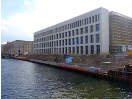
Fig. 10. Obras de construcción de la fachada posterior del Humboldt Forum, en 2018 (fotografía de la autora).
