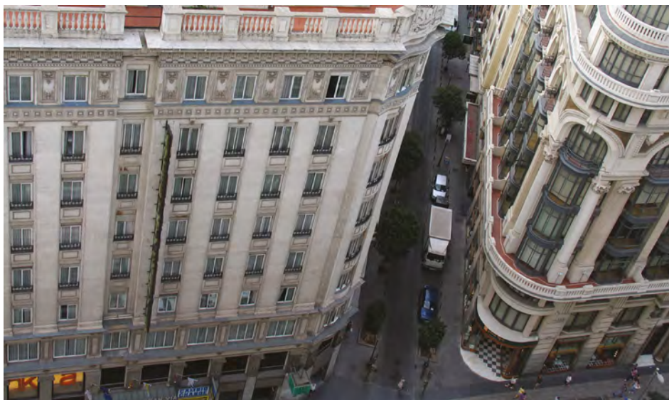
Fig. 18. Vista de la Gran Vía desde el edificio Telefónica. Fotografía por José Juan Barba, 2010.
