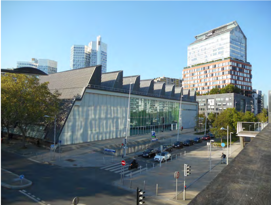
Fig. 5. Edificio 57. Metal en plena rehabilitación-transformación con las estructuras de los sheds visibles. Boulogne-Billancourt (Fotografía, Pilar Aumente, 2018).
