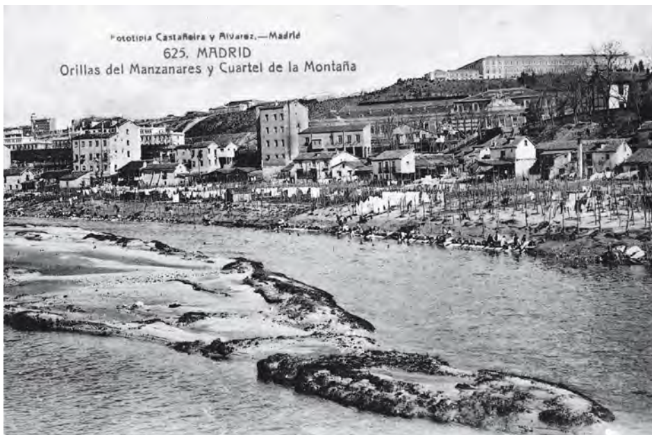
Fig. 2. Tarjeta Postal. Madrid, orillas del Manzanares y Cuartel de la Montaña (h. 1911-1915). Bajo el Cuartel de la Montaña se ven los dos volúmenes destacados de la Estación del Norte y del Asilo de Lavanderas antes de descender a las pequeñas edificaciones próximas al río y los lavaderos.
