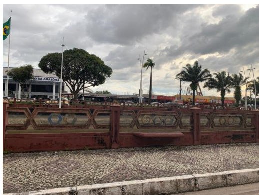
Figura 6. Guarda-corpo do canal. Fonte: Registro dos Autores.
