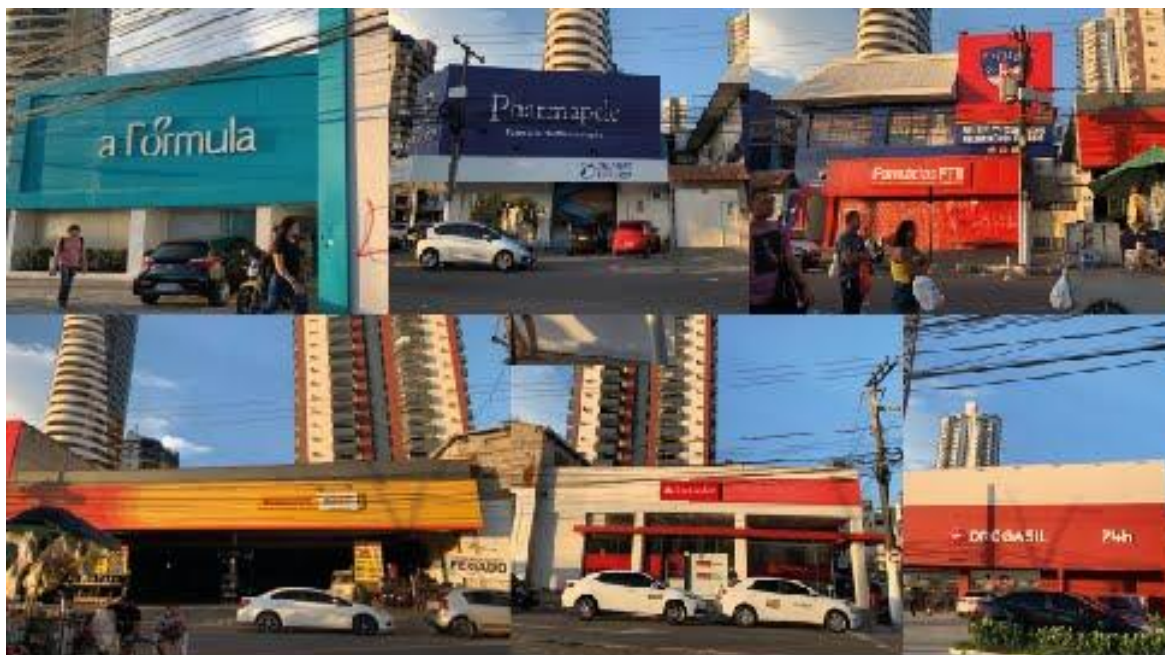
Figura 14. Fachadas, trecho 03. Fonte: Registros e criação dos Autores.
