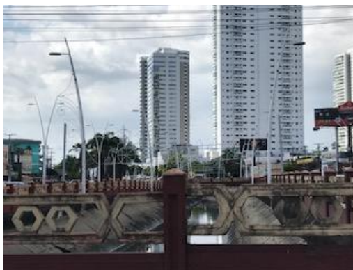
Figura 5. Canal da Avenida. Fonte: Registro dos Autores.
